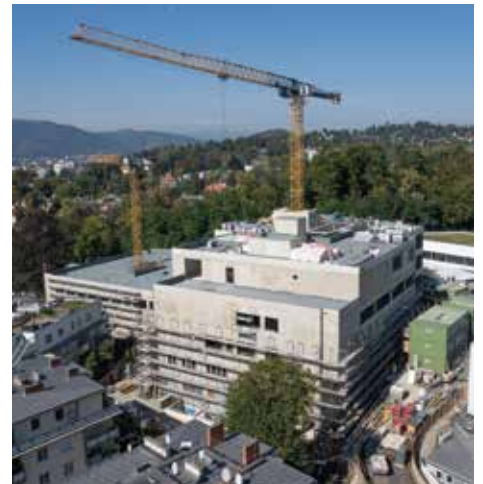
Rohbau der Radiologie NEU am Uniklinikum Graz
